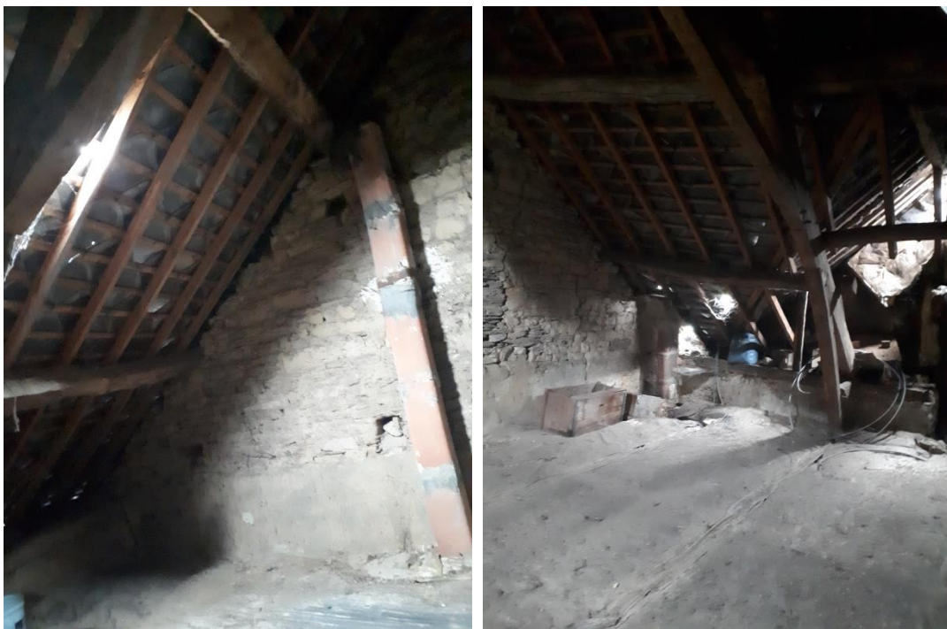
Ouvertures dans le toit du bâtiment de la parcelle 205 © LPO Bretagne
