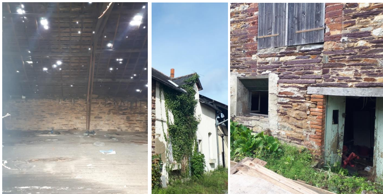
Exemple de combles favorables à l'accueil de chiroptères mais non accessibles car planchers instables, mur en pierres et cave du bâtiment de la parcelle 210 © LPO Bretagne
